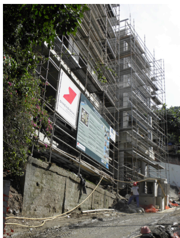
Figura 43 – Construção de Conjunto habitacional na Ary Barroso.
