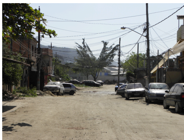
Figura 13 – Rua em Área Verde, local onde há incidência de alagamentos.
