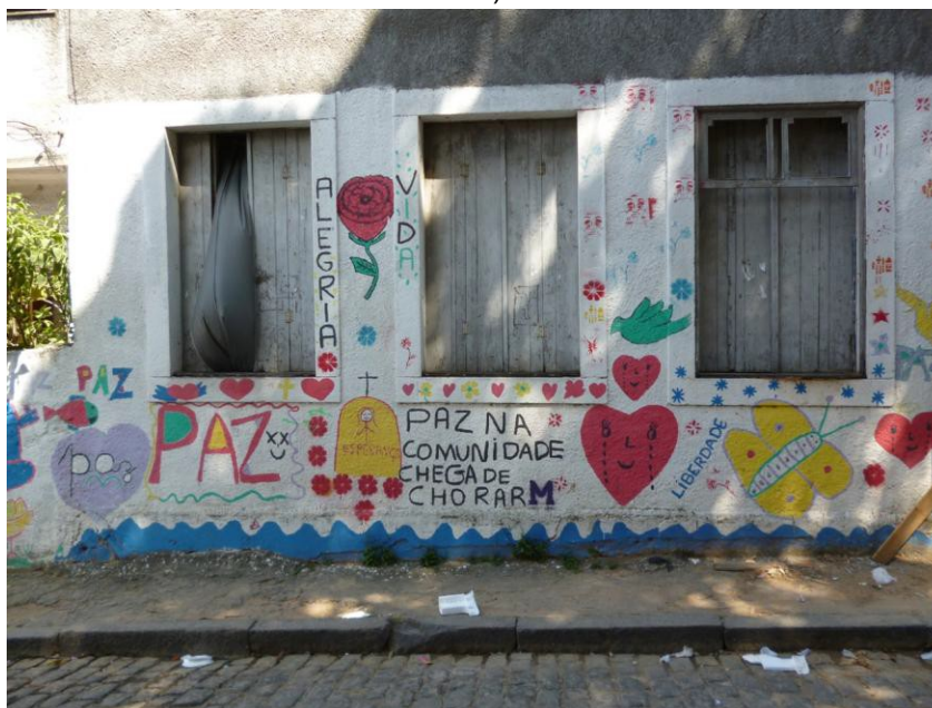
Fotografia 17: Casa ameaçada na Ladeira do Barroso em função da construção do teleférico e de um prédio para moradia popular (fev. 2012)
