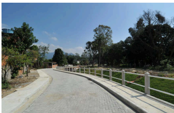
Figura 26 – Intervenção às margens do rio em Entre Rios (fonte: material informativo da SMH).
