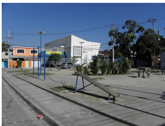
Figura 27 – Praça concluída em Entre Rios e ao fundo uma EDI.
