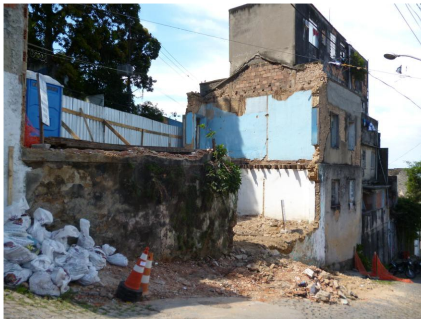
Fotografia 18: Fachada dos fundos de casa na Ladeira do Barroso e demolição de casa vizinha (fev.2012)
