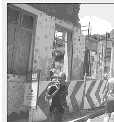
Algumas casas que foram muradas há mais de 100 anos na comunidade do Centro do Rio já foram demolidas.
