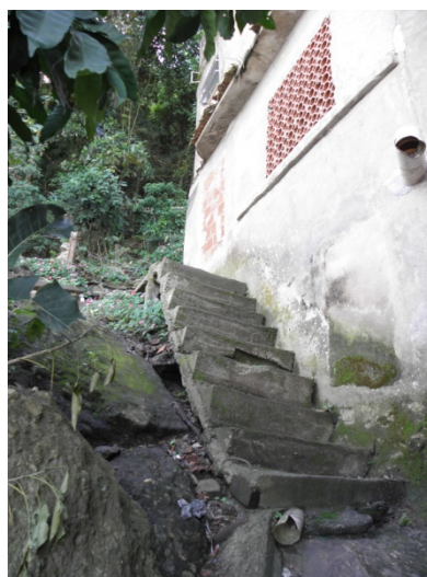
Figura 33 – Escadaria íngreme – Chapéu Mangueira.
