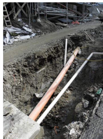
Figura 45 – Obra de infraestrutura – Babilônia.
