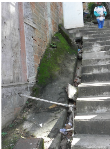
Figura 41 – Escadaria reformada (íngreme); precariedade da infraestrutura.
