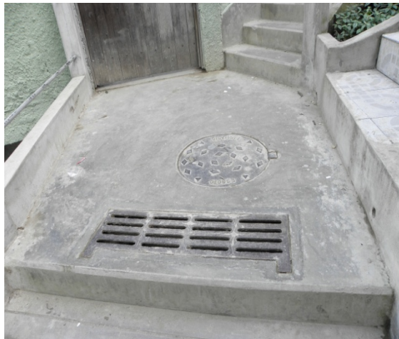
Figura 47 – Obras de pavimentação e infraestrutura.
